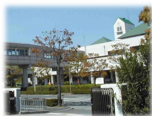
ほほえみの橋
